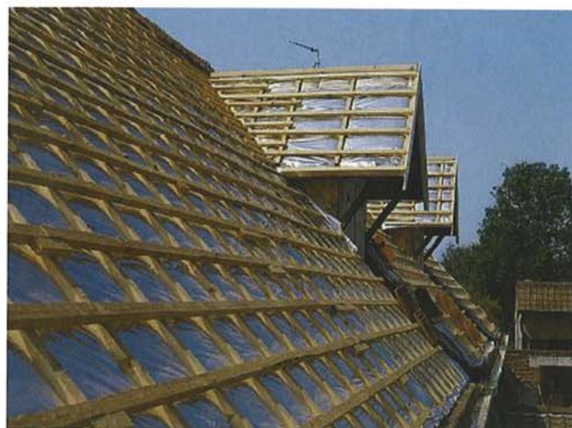
Artikkelforfatter Sivert Uvsløkk gir en detaljert framstilling av hvordan reflekterende folie påvirker varmeoverføringen i hulromskonstruksjoner. Sivert Uvsløkk advarer sterkt mot bruk av plast og aluminiumsfolie på den kalde siden av konstruksjonen. Et slikt damp-tett sjikt vil kunne føre til oppfukning ved kondens, med påfølgende råteskader. Her er et eksempel hvor slike reflekterende isolasjonsmatter er lagt direkte på taksperrene, under sløyfer, lekter og etter hvert takstein.
